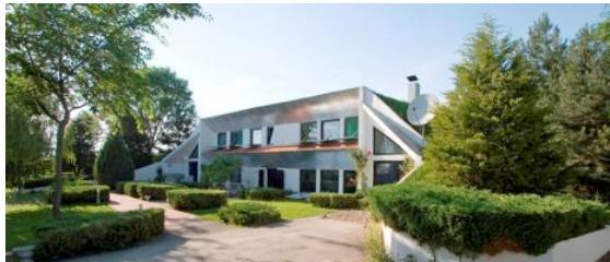
Koncept „Samogrejne ekološke kuće“ Veljka Milkovića predstavlja visokoenergetski efikasan građevinski objekat pasivne solarne arhitekture koji se greje pomoću sunčeve energije okrenut ka jugu sa instaliranim reflektujućim površinama oko prozorskih okvira, kao inovativnom solarnom tehnologijom uvećanja toplosti i svetla koje ulazi u objekat, i zemljanim omotačem oko konstrukcije kuće za maksimalno zadržavanje besplatne
