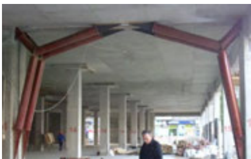
Slika 5. Montaža ukrućenja SISTEMA DC90 poslovnom molu u Baku-Azerbejdžan
