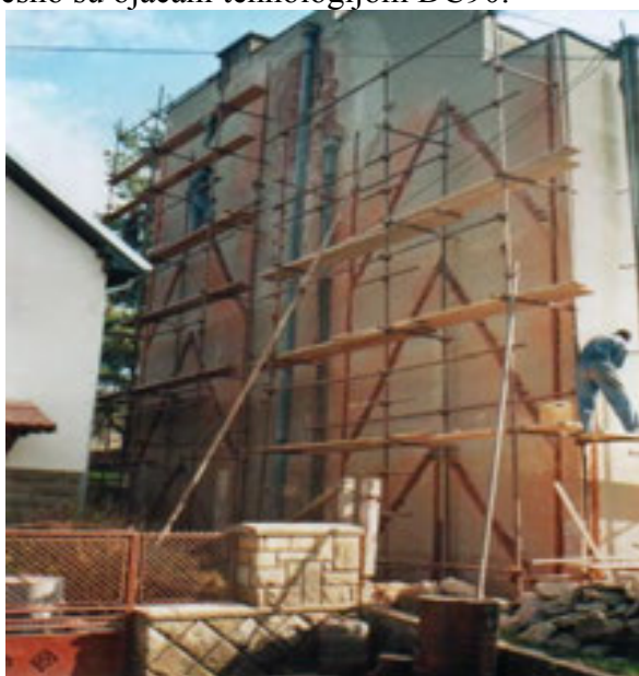
Slika 3. Sanacija zidanog objekta P+3 tehnologijom DC90 (levo) i spratni zidani objekat u Ljigu (desno).
