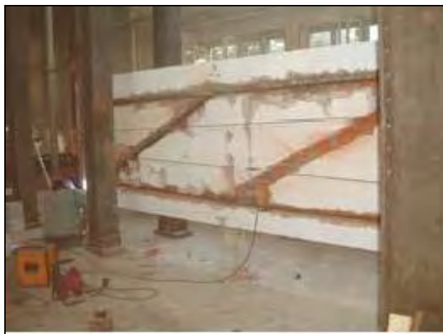
Slika 1. Testiranje dvoetažnog zida ojačanog Sistemom DC90 sa Damperima na kvazidinamičko opterećenje u hali Instituta IMS (gore) i snimak zida u procesu ojačanj (dole).
