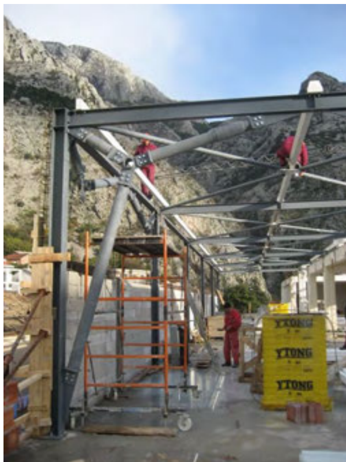
Slika 5a. Montaža ukrućenja SISTEMA DC90 na objektu u Kotoru
