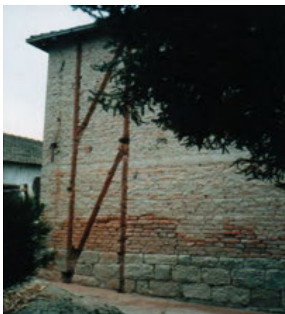
Slika 3. Sanacija zidanog objekta P+3 tehnologijom DC90 (levo) i spratni zidani objekat u Ljigu (desno).
