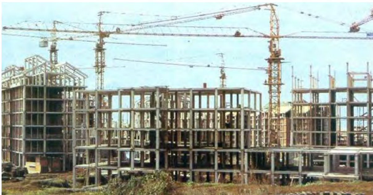
Slika 5: Izvedena skeletna konstrukcija sistema IMS-Žeželj [4]
