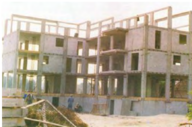
Slika 7. Građenje objekta u Sistemu 50 [4]
